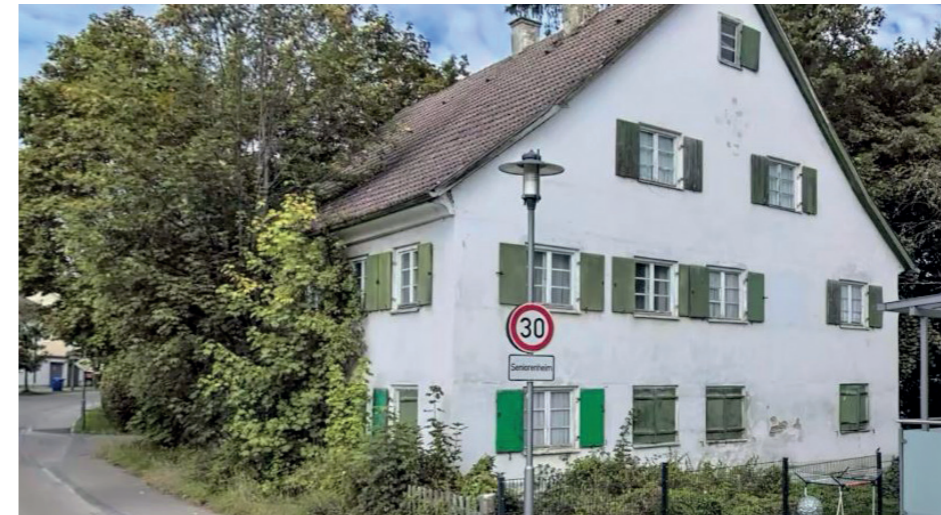
ALTES WOHNHAUS (KRANKENHAUSSTRASSE 8) WURDE ABGERISSEN
