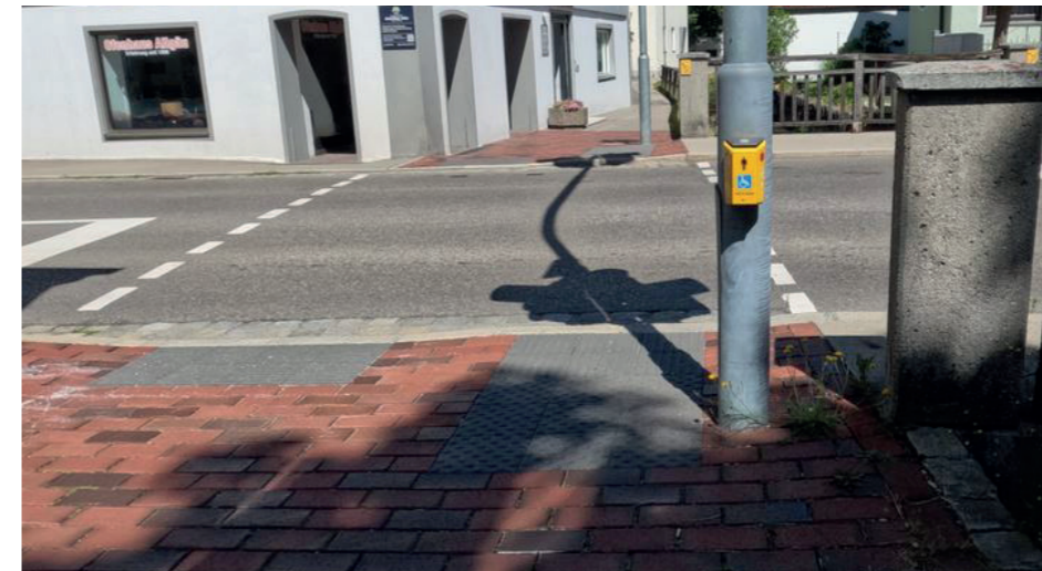
BARRIEREFREIER ÜBERQUERUNGSSTELLE AN LICHTSIGNALANLAGE MIT BODENINDIKATOREN IM ZENTRUM AM UNTEREN MARKT
