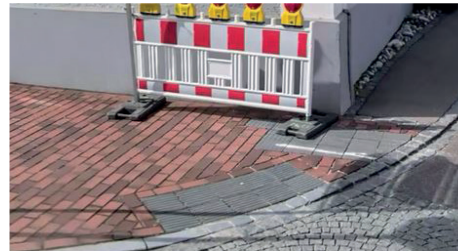
BARRIEREFREIER ÜBERGANG MIT BODENINDIKATOREN ECKE KRANKENHAUSSTRASSE
