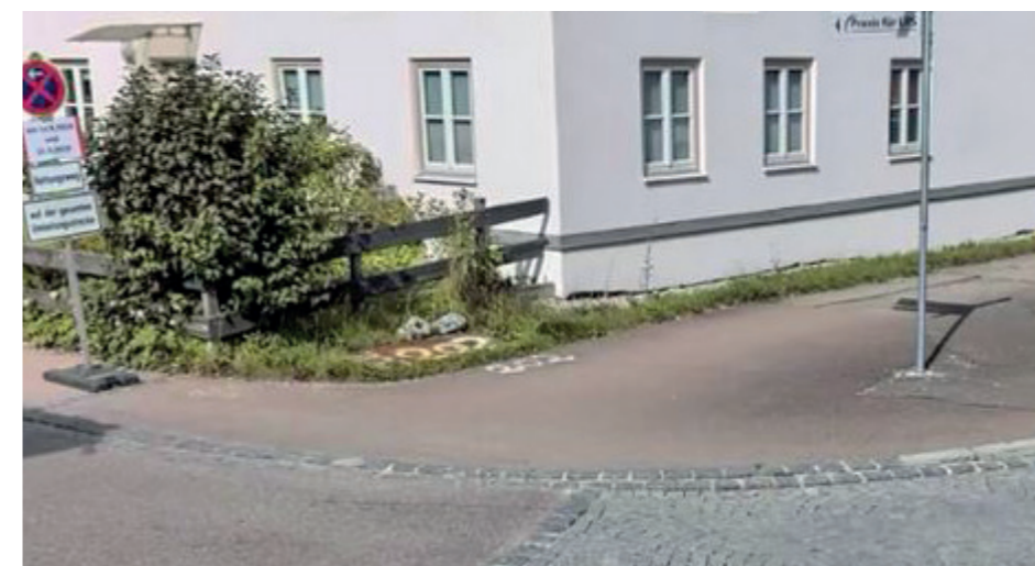
FEHLENDE FORTFÜHRUNG MIT BODENINDIKATOREN AUF GEGENÜBERLIEGENDER SEITE ECKE KRANKENHAUSSTRASSE
