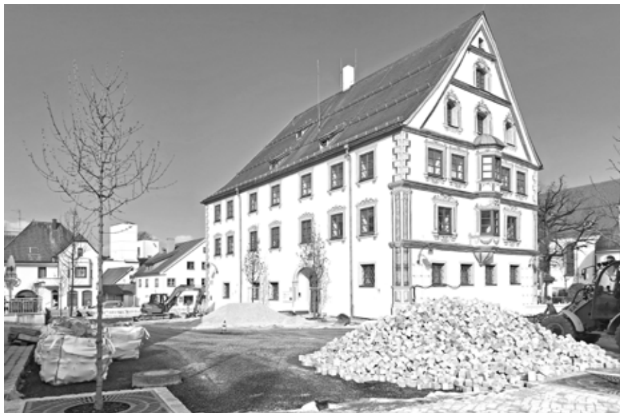
Die Firma Freiraum Schmid saniert seit Februar den Marktplatz in Obergünzburg. Die Fertigstellung ist für Mitte Juli geplant. Foto: Michaela Wölfl/Markt Obergünzburg
