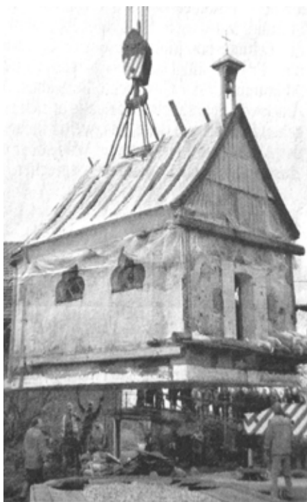
Mit einem riesigen Kran wurde die Kapelle vor 25 Jahren versetzt und zeigt sich jetzt nach der Renovierung als ein schmales Kleinod. Fotos: Hermann Knauer (Repro)
