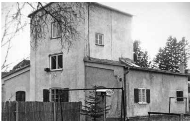
Das sogenannte Gashaus mit außergewöhnlichem Baustil diente neben der Azetylen-Gas Herstellung nach dem 1. Weltkrieg bis in die 1977er Jahre als Wohnung und Unterkunft und Arbeitsraum verschiedener Einrichtungen. Foto: Hermann Knauer (Repro)
