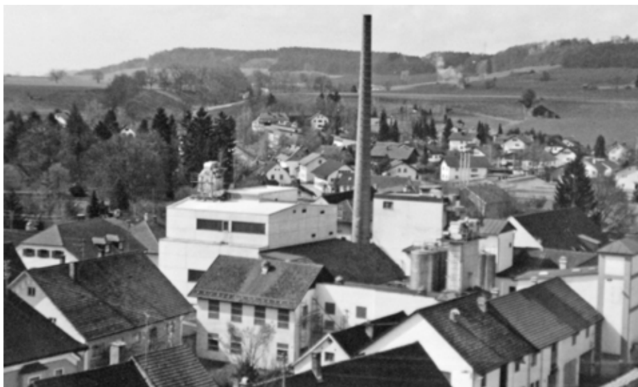
Seinerzeit vor 60 Jahren kennzeichnete ein hochragender Schlot die Lage des Milchwerks Gabler Saliter.
