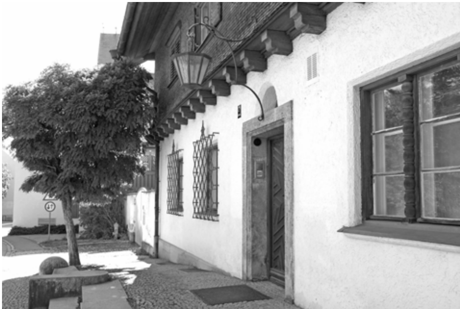
Das geknickte Satteldach und die faszinierende Verschindelung des Obergeschosses vermittelt noch heute eine faszinierende Architektur.
